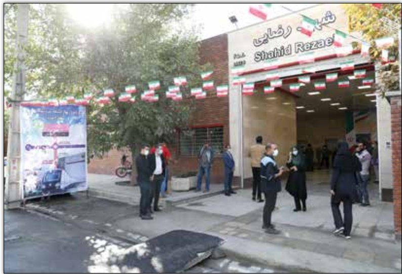
ایستگاه شهید رضایی، سیزدهمین ایستگاهی است که در خط ۶ راه‌اندازی شده و در مجاورت خیابان‌های پرترددی از قبیل ۱۷ شهریور، شهید رضایی(منصور) و تیردوقلو، مسافران پرشماری از مناطق ۱۲ و ۱۵ خواهد داشت.
